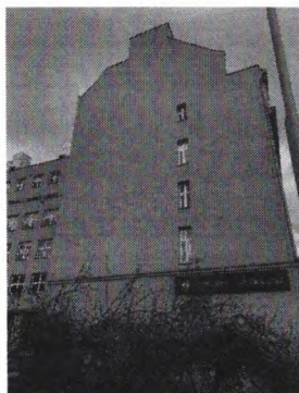
Elewacja od strony ul. Traugutta – miejsce na reklamę WZSOZ.
